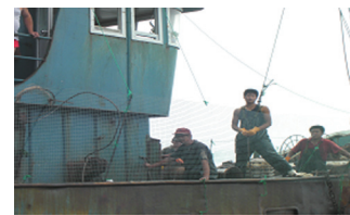
현측 철조망 설치
