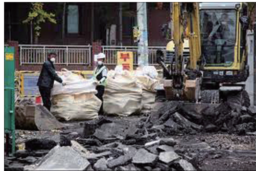
노원구 도로철거 현장
