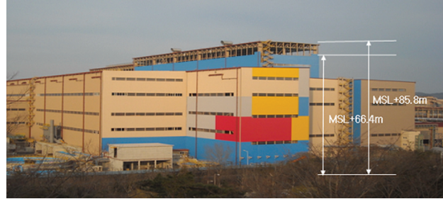
포스코 신제강공장 전경
