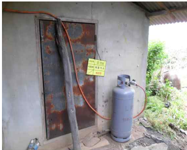
< 부적합하게 호스로 설치된 시설 > < 적합하게 배관으로 설치된 시설 >
