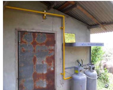
< 부적합하게 호스로 설치된 시설 > < 적합하게 배관으로 설치된 시설 >
