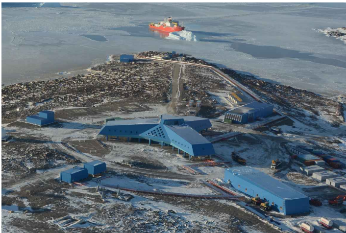
< 남극 장보고과학기지 전경 >
