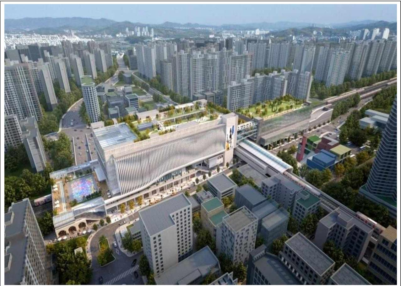
\* 현재 2층(대합실) 게이트(서교공)를 통과하여 1층 1호선(코레일)과 3층 4호선(서교공) 이용 중이며, 민자역사 건설에 따라 3층에 환승통로 게이트 추가 설치 계획(기존 게이트 존치)
