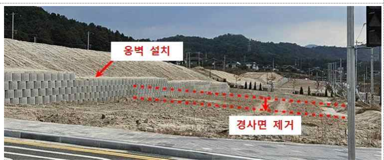
공사 완료 후(경사면 제거, 옹벽 설치)
